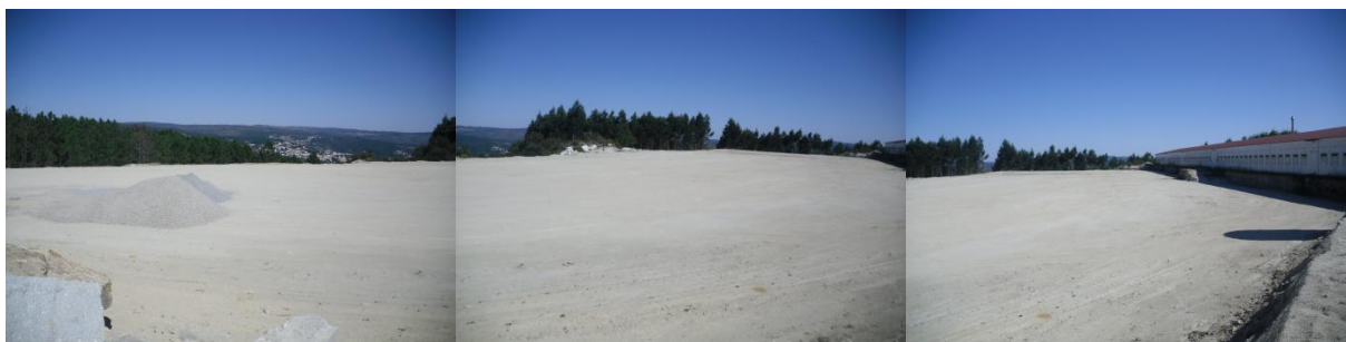
Foto 5: Vista do local onde será implementado o pavilhão novo
